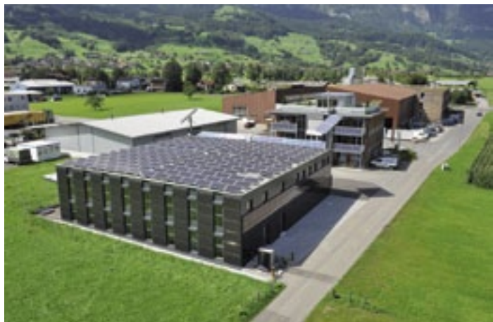
01 Der Plusenergiebau in Gams (atm3, Grabs) verfügt über zwei fassadenintegrierte PV-Anlagen, eine aufgeständerte Dachanlage und zwei Nachführsysteme, die 60.6 kWp leisten (Fotos: Schweizer Solarpreis 2011)
