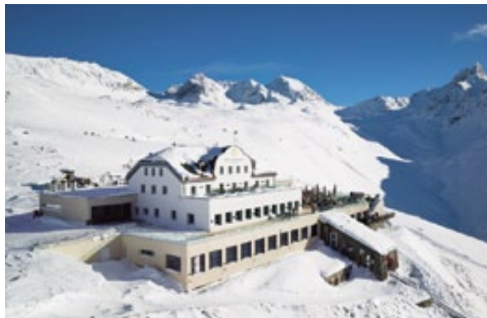
02 Auf 2456 m Höhe erreicht das Plusenergiehotel in Samedan (Fanzun Arch. + Ing., Chur) durch die Kombination von Flach- und Röhrenkollektoren und einer PV-Anlage eine Eigenenergieversorgung von 105%
