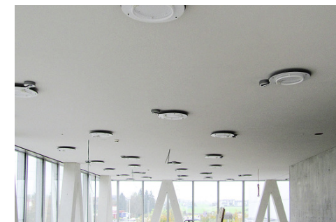
Oberflächenoptik mit Akustikspindel der thermisch aktivierten Decke mit verlegten Bauteilelementen Sorp 10. Fotos Max Frank GmbH & Co. KG
