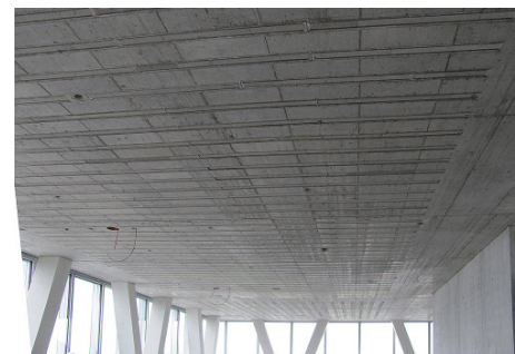
Die ursprüngliche Deckenoberfläche zeigt die im Abstand von 27 cm eingelassenen Absorberbauteile.
