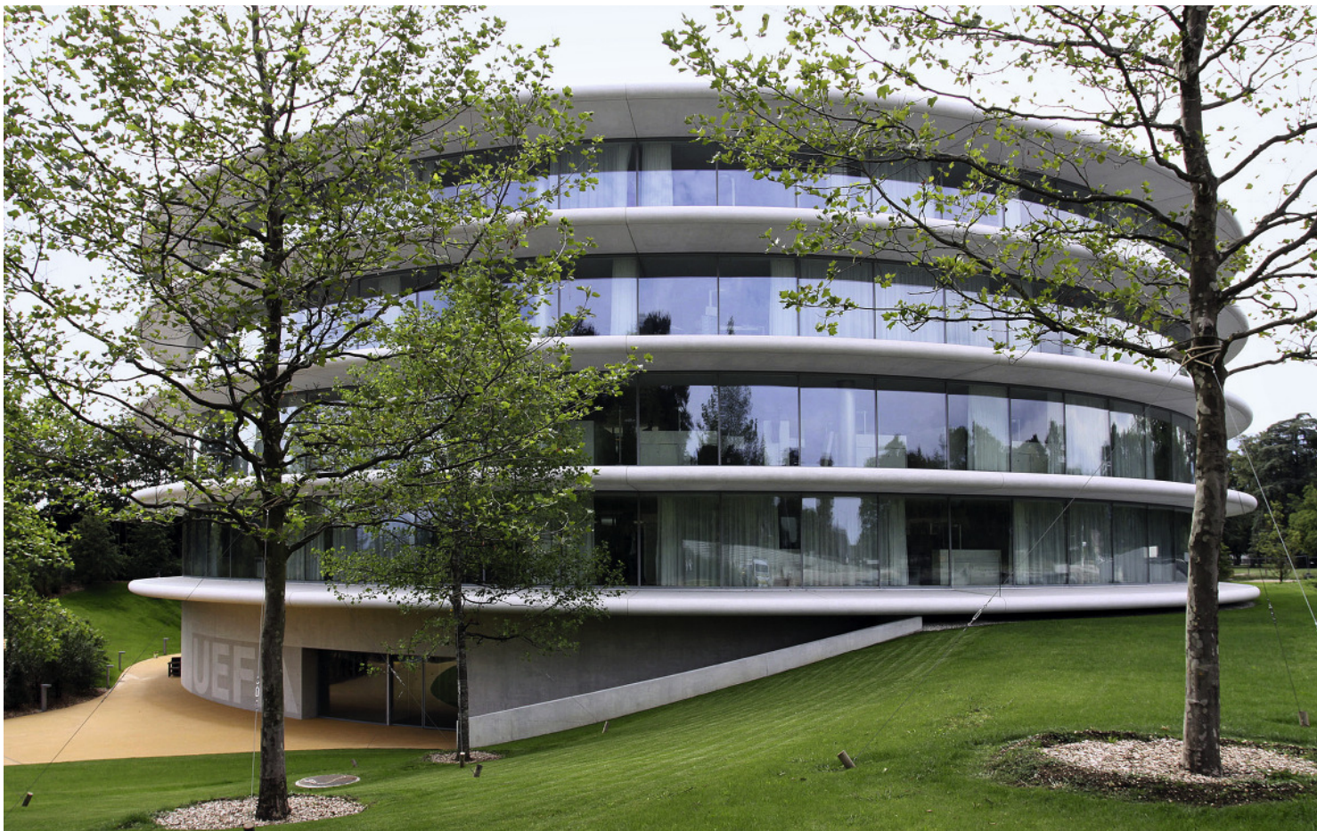
Der Sonnenschutz des Verwaltungsgebäudes des Europäischen Fussballverbandes besteht aus Betonfertigteilen, deren Tiefe zwischen 1,80 und 3,00 Meter variiert.
