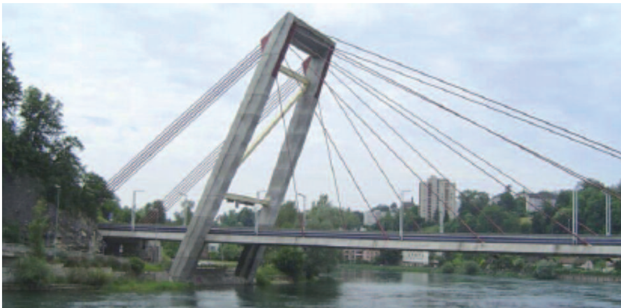
Abb. 3: Beim Bau der Rheinbrücke Schaffhausen (1995) wurde hochlegierte Bewehrung für die Pylons und die Konsolköpfe eingesetzt. Für die innere Bewehrung wurde normaler Stahl verwendet.
