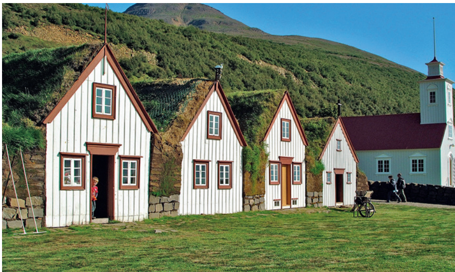
Die Nordländer wussten schon lange um die isolierende Wirkung von grasbedeckten Häusern, wie hier auf dem um 1850 erbauten Landwirtschaftsgut im nordisländischen Laufas.
