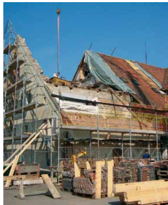
Das Dach über dem Ökonomieteil musste teilweise ersetzt werden.
