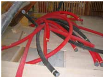
Für die Lüftungsinstallation mussten Dutzende Kanäle von den Lüftungsanlagen in die unteren Stockwerke verlegt werden.
