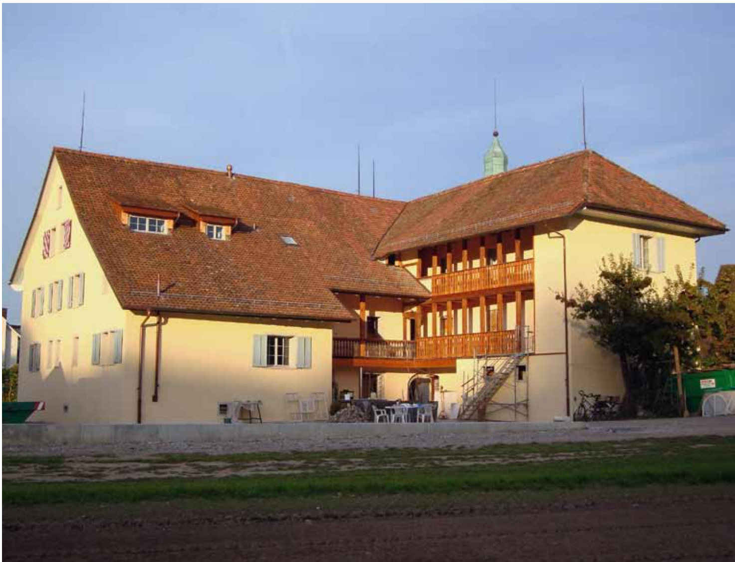
Seit letztem Herbst zeigt sich das aus dem Jahr 1528 stammende Fahrhut wieder in alter Pracht. Dank Solaranlage und mechanischer Belüftung kann das Fährhaus an der Reuss als erstes Denkmalobjekt im Kanton Aargau mit einem Minergiezertifikat ausgezeichnet werden.
