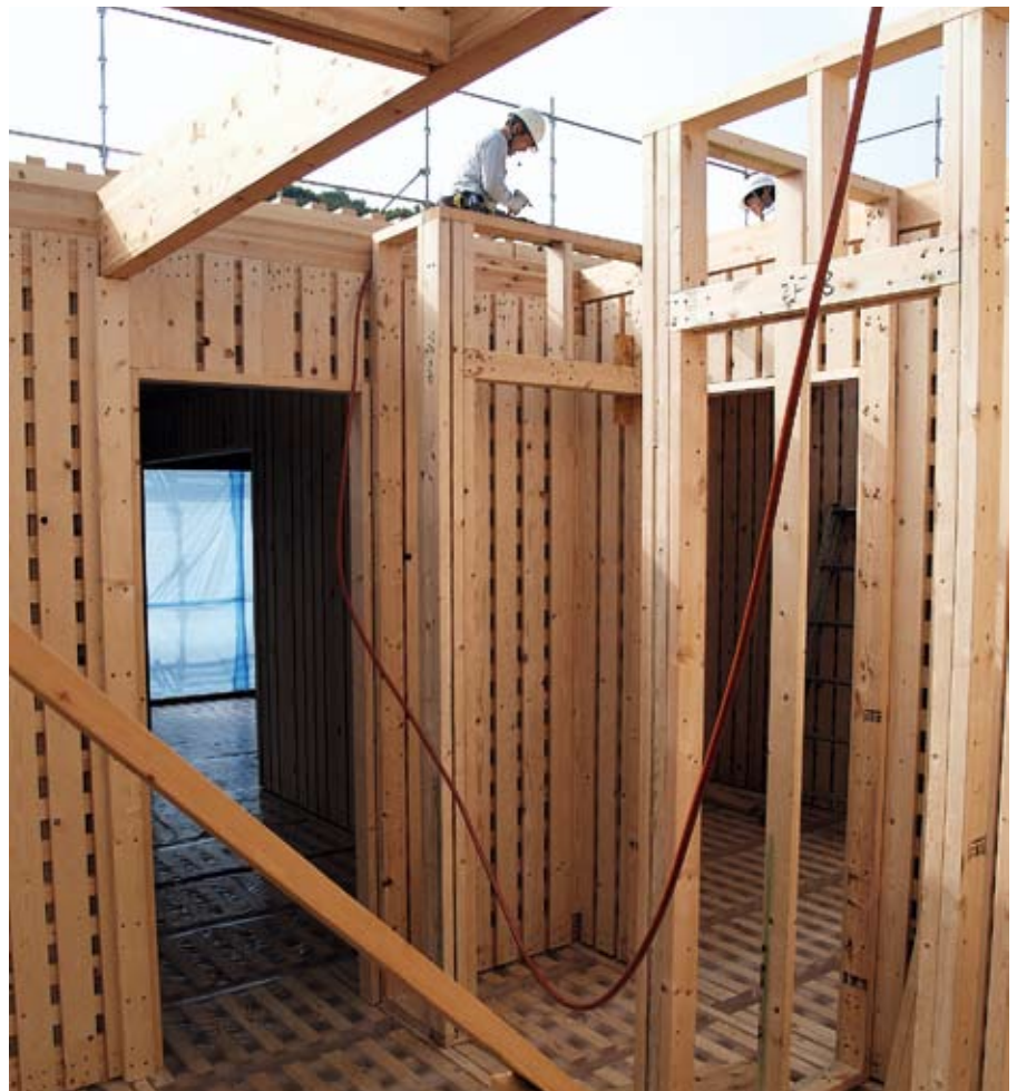
Kreuzweise verleimte Holzelemente von Lignotrend erweisen sich als ideal für Japans Erdbebensituation. Derzeit entsteht in Kyoto ein Pilotheaus. Fotos SBC
