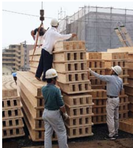
Konstruktive Deckenelemente auf einer japanischen Baustelle.
