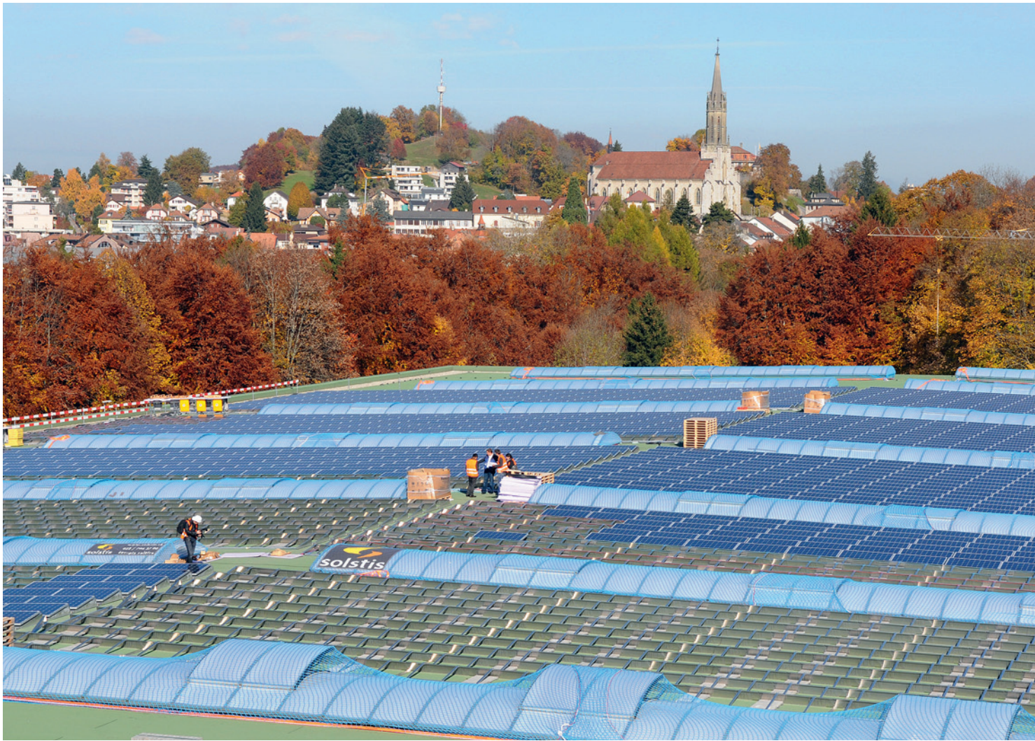
Auf dem Dach der Swisspor Romandie SA entsteht eine Photovoltaik-Anlage, die jährlich über 1 Million kWh produzieren soll.
