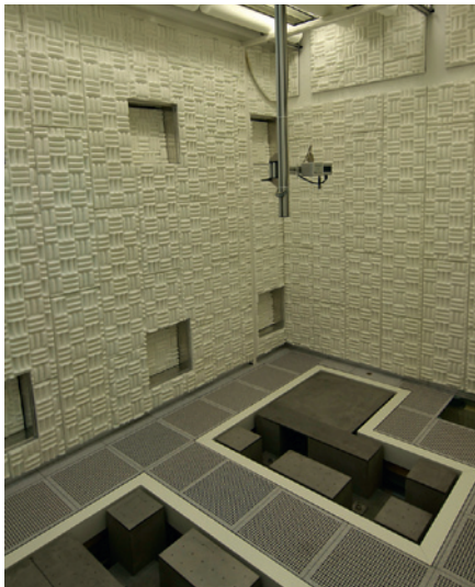
Zur Minimierung von Erschütterungen wurden spezielle Baumassnahmen umgesetzt: luftgedehrte Betonsockel und freischwebend aufgehängte Fussböden. Foto IBM
