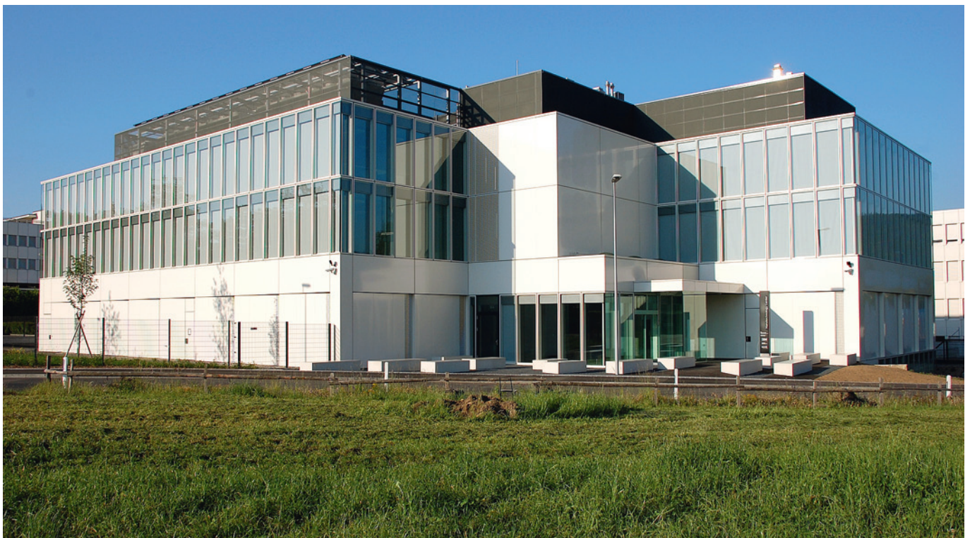
Mit einem Minergie-konformen Haustechnikkonzept, dem Einsatz von energetisch optimierten Baumaterialien und Dämmstoffen, von Erdsonden sowie einer Photovoltaikanlage erfüllt das neue Forschungsgebäude in Rüschlikon die hohen Anforderungen an die Energieeffizienz.
