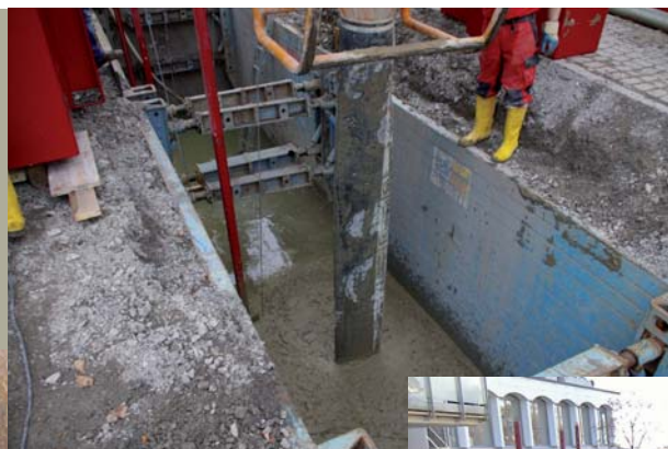
Einbau von RSS-Flüssigboden bei stehendem Grundwasser (Logic Schweiz).
