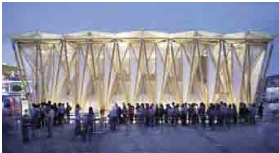
01 Deutsch-chinesisches Haus an der Expo 2010 in Schanghai. Hier wurde erstmals eine an der TU Darmstadt entwickelte Technik für Bambuskonstruktionen angewendet, die auf den Arbeiten des Architekten Simón Vélez beruht. Architektur: MUDI/Munich Urban Design International, Schanghai (Foto: MUDI)
