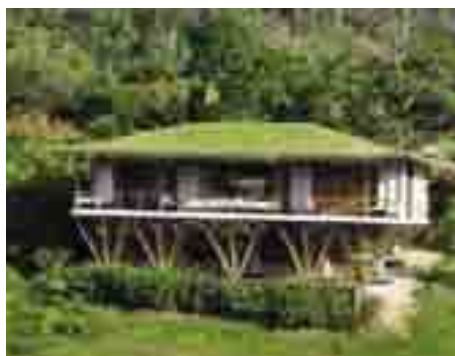
03 Ein anspruchsvolles Wohnhaus aus Bambus in Bahia (Brasilien). Auch die schräg gestellten Stützen bestehen aus Bambus
