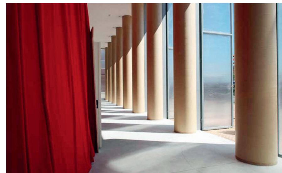
Diese Röhren sind von Pappe: Die sechs Meter hohen Bauteile stützen die Halle trotzdem zuverlässig ab.
