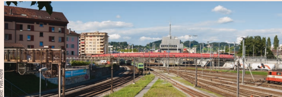
Die Balkenbrücke bringt städtebaulich Ruhe in das wilde Umfeld mit den vielen Masten und Leitungen.
