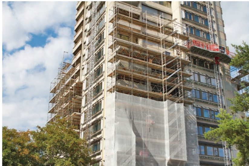
Für die Aussenarbeiten mussten die Gerüste mit Mastkletterbühnen kombiniert werden.
