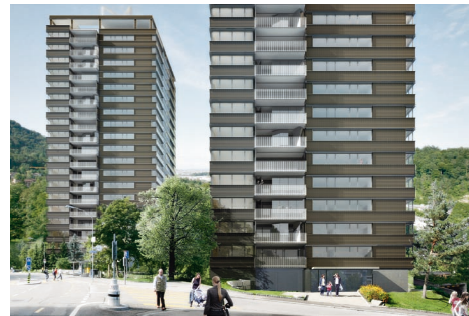
Die Photovoltaik-Panels fungieren als hinterlüftete Fassadenbekleidung und als Witterungsschutz.
