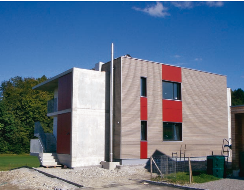
Der Clou des Hauses steckt hinter der Fassade: die ausgeklügelte Haustechnik.
