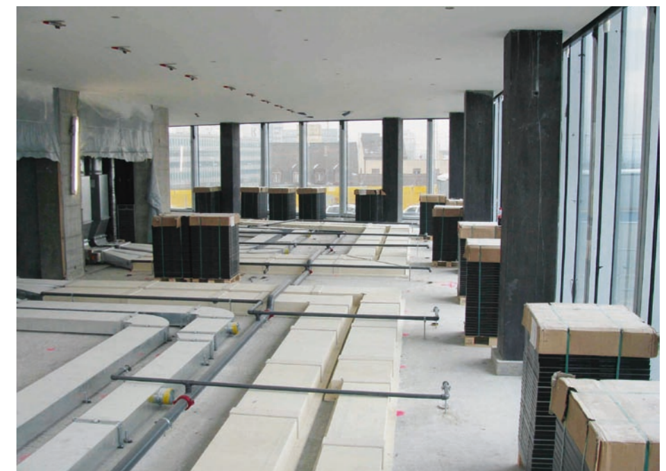
Elf Kilometer Schächte und Kanäle wurden mit Promat-Brandschutzplatten im Prime Tower verbaut.
