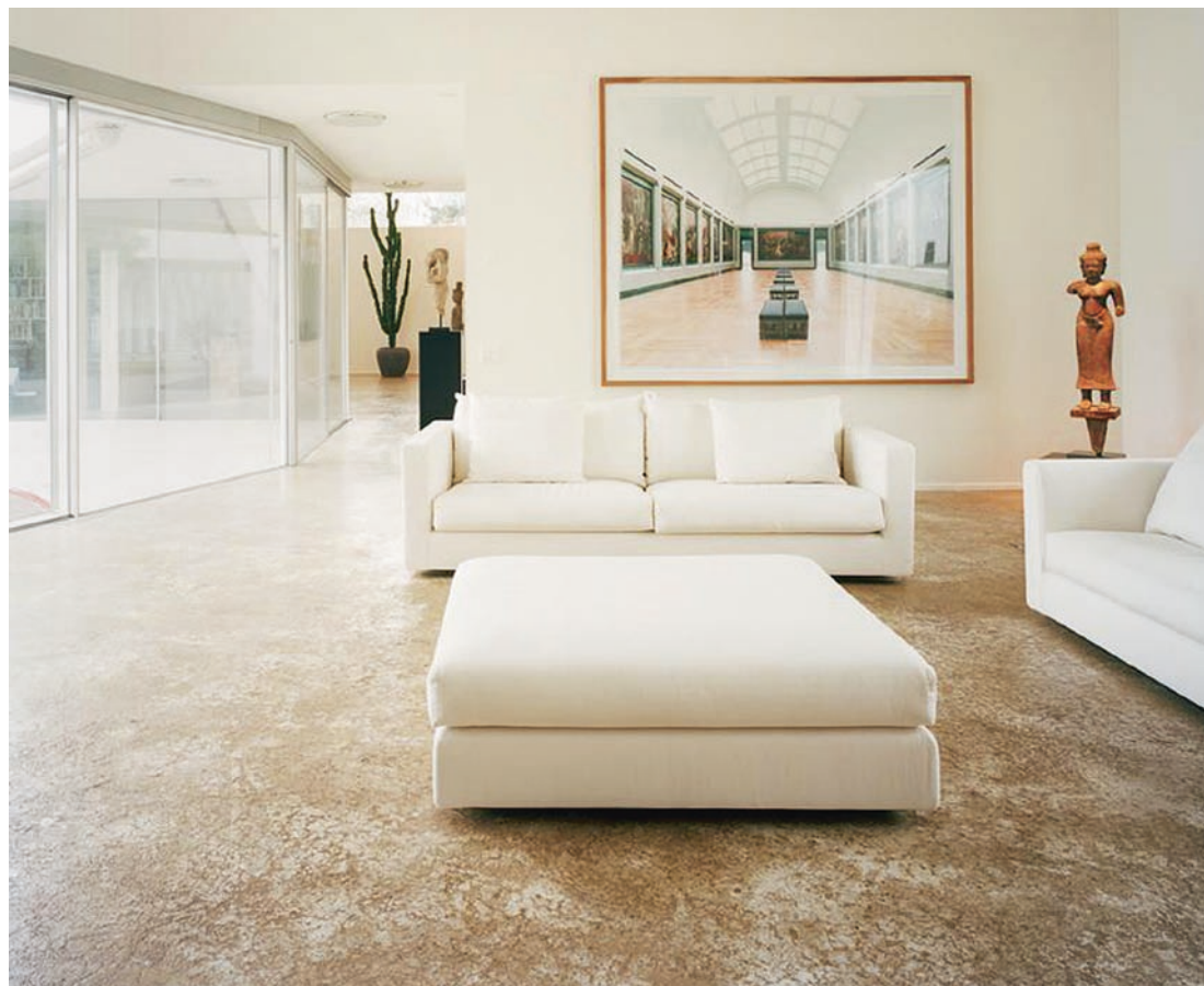
Lehmboden in 13 Arbeitsgängen: Das Haus eines privaten Kunstsammlers in Binningen BL.
