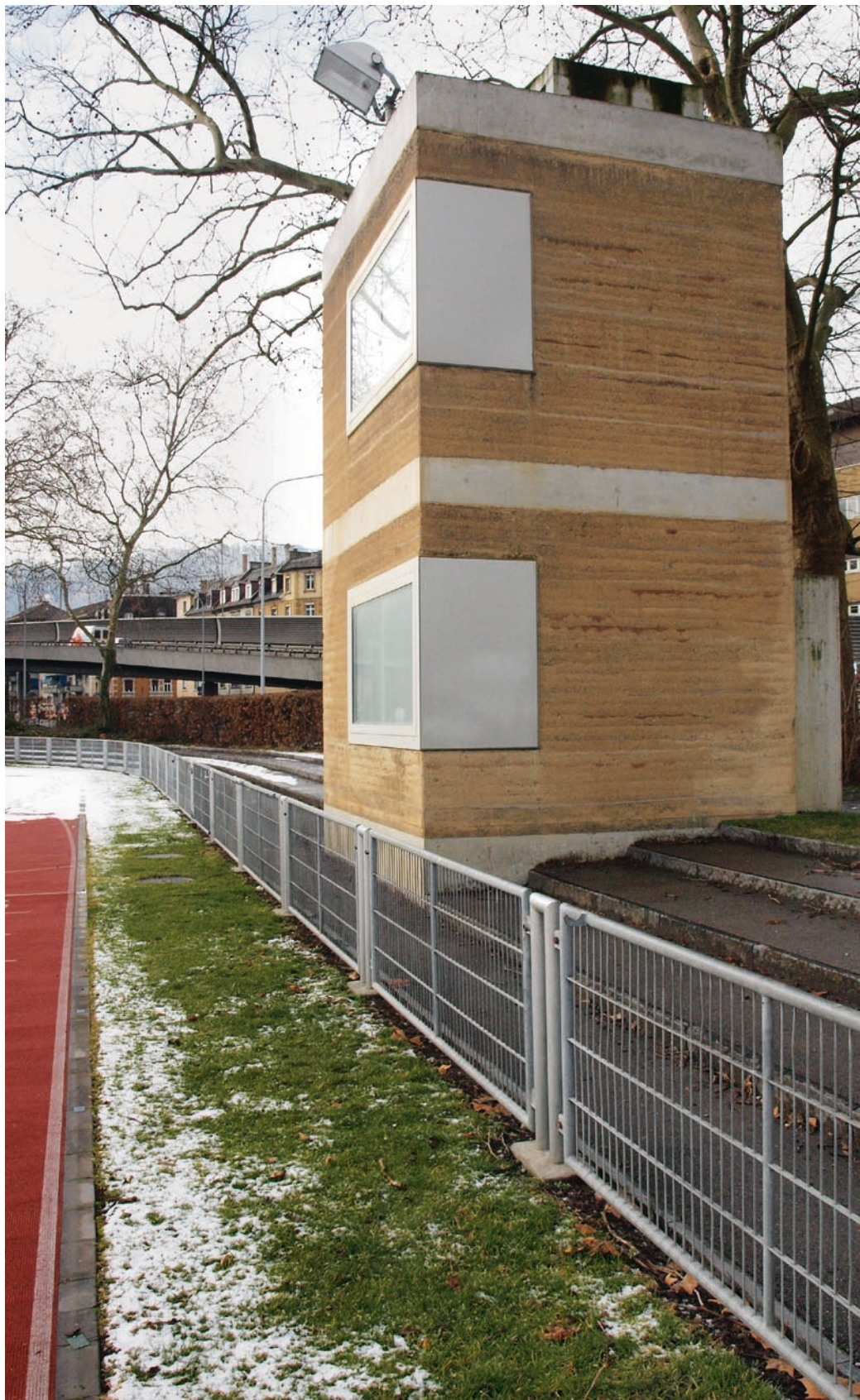
Zielturm der Sportanlage Sihlhölzli: Die Wände sind aus Stampflehm, Dach und Böden aus Sichtbeton.
