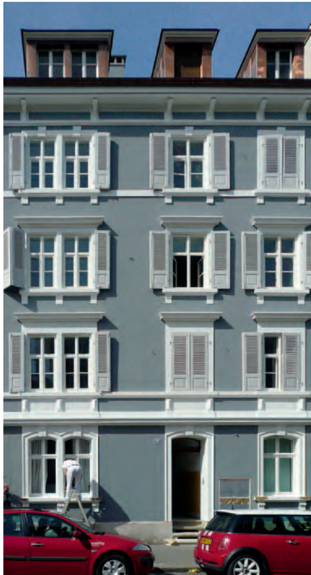
Ansicht der historischen Fassade an der Mühlhauserstrasse in Basel.
